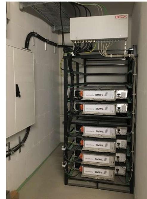
Industriebetrieb: 7.000 Stundenregel - Speichercontainer 480kW / 1008kWh
