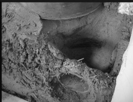
Mettez en forme cette partie avec des plaques de métal et un mortier argile-sable sans paille. Veillez à obtenir les parois et le fond le plus lisse possible, afin que les outils de nettoyage puisse les ratisser sans accroc.
