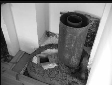
Le mélange isolant a besoin d'être placé dans un conteneur cylindrique autour de la cheminée interne et à l'intérieur de l'échangeur thermique (le baril), mais aussi jusqu'au niveau de la sortie du flux vers le conduit horizontal. Un réservoir de ballon d'eau chaude électrique est juste à la bonne dimension si vous coupez ses extrémités. Si vous n'avez pas de vieux chauffe-eau disponible, une feuille ou un treillis métallique peut être roulé et attaché pour devenir le conteneur.
