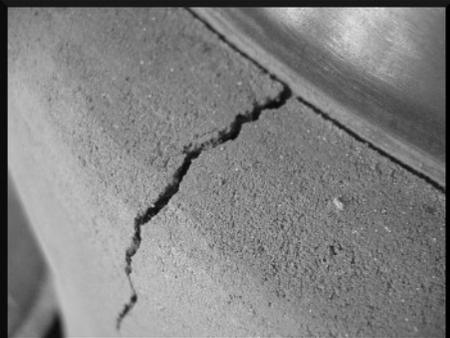
Des essais ont été réalisés avec un mélange perlite-terre pour ménager un espace de tampon entre un poêle incrusté dans un mur en bauge. Une autre solution est d'accueillir les fissures, les autoriser, et les guider en incisant la surface. Ainsi la fissuration a lieu selon votre dessin. Assurez vous que les incisions soient superficielles et que le mortier est hermétique autour du baril afin que les gaz ne puissent pas s'échapper et vous intoxiquer.
