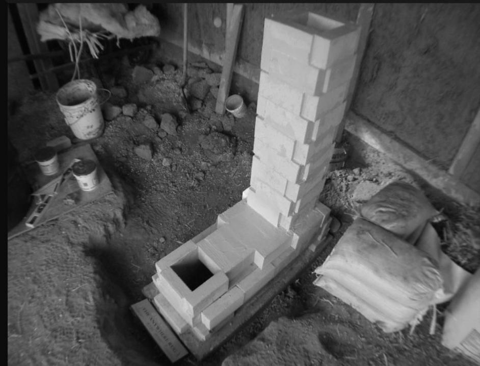
Il est possible de construire le tube d'alimentation et le tunnel de combustion en briques et d'utiliser un tube en acier pour la cheminée interne. L'acier à cet emplacement sera plus durable que s'il est utilisé en amont du flux de la combustion, là où il y a plus d'oxygène.
