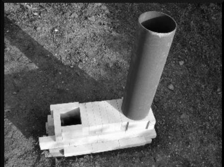
Commencez par poser vos briques sur une surface plate incombustible, à l'extérieur de préférence, juste pour s'entraîner à les assembler entre elles. Il est fortement recommandé de construire une maquette complète de la structure, sans mortier, et d'y réaliser un feu bien chaud pour s'assurer que cela fonctionne.
