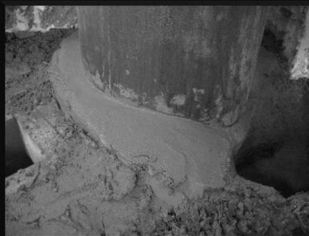
Afin de permettre un mouvement fluide des gaz entre l'espace confiné contre la paroi interne du baril et la masse thermique, il est nécessaire d'aménager dans le bas du baril, un canal circulaire, tout autour de la cheminée interne, qui aura pour fonction de diriger le flux vers le conduit horizontal du lieu de stockage de la chaleur.
