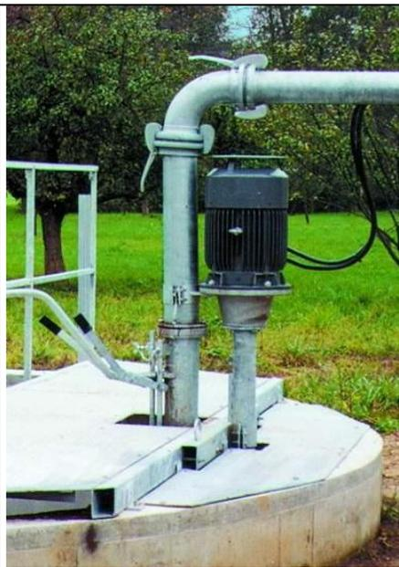
Complètement descendre la pompe jusqu'au fond de la fosse, la dresser en position verticale, et la fixer sur la traverse au moyen d'un collier mis autour de l'arbre d'entraînement. La traverse et, le cas échéant, une plate-forme de travail sont installés sur la fosse / le réservoir.
