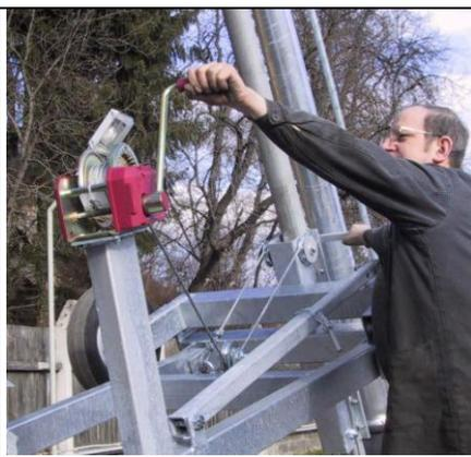
Doucement dresser la pompe au moyen du treuil et la descendre simultanément en relevant le levier de retenue.
