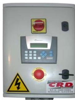
L'armoire de commande est montée dans un coffret électrique IP 55, avec en option : démarrage automatique, horloge et mise hors gel.
