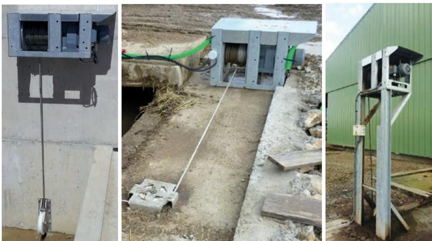
Treuil motorisés de 0,75 CV à 1 CV pour enroulement et déroulement de la corde.
