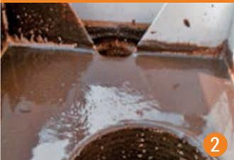
Le réservoir de mesure (contrôle du flux) alimente le bassin de floculation avec une quantité fixe d'effluents, l'excès revenant vers le réservoir de stockage.
