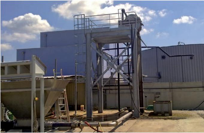
L'inclinaison à contre-sens de la pente du tamis peut être réglée s'il est nécessaire de séparer les matières plus longuement.
