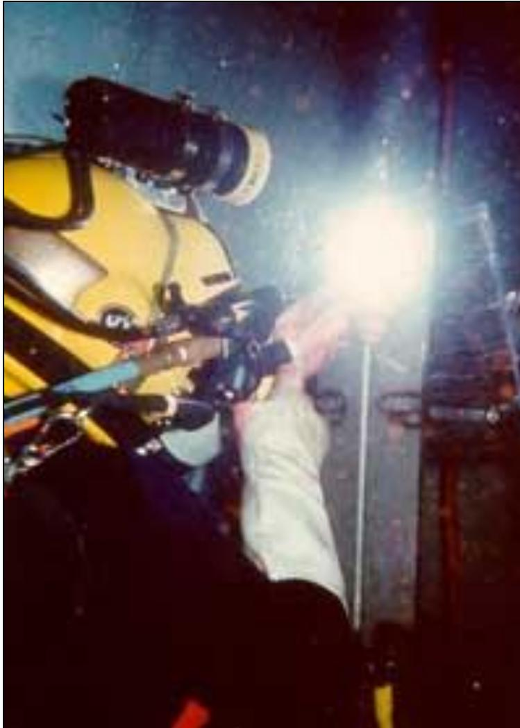
Depuis 2001 nous avons maintenant en Europe la nouvelle norme EN ISO 15618-1 qui définit les principes à appliquer pour la qualification des plongeurs soudeurs.
