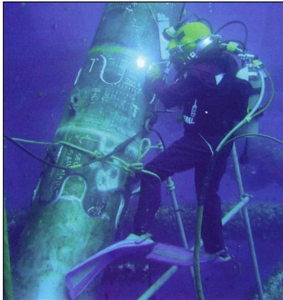
Il en va de même pour les câbles de soudage où il faut éviter que de grande longueur traîne inutilement dans l'eau et risque ainsi d'offrir une prise au courant ou d'exercer une traction sur la pince porte - électrode et / ou la pince de masse.
