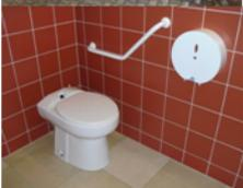
**Les toilettes sèches fonctionnent sans eau de dilution ni de transport** (définition incluse dans l'arrêté du 7 septembre 2009) et sont associées à un **processus de traitement de nos excréments appelé compostage, d'où leur nom de toilettes à compost**. L'utilisation de toilettes sèches devra être associée à un traitement des eaux ménagères c'est-à-dire à un dispositif d'assainissement des eaux grises.
