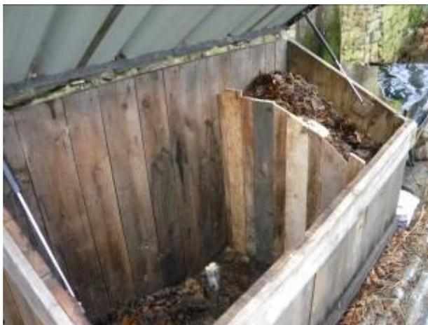
Photo 3 : Composteur de St Barthélémy, aire non étanche et à gestion optimisée (1 compartiment). Le petit compartiment à droite permet de stocker la matière carbonée pour le compost.
