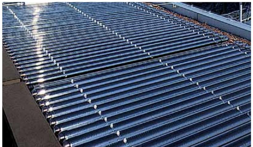
Fig. 3.6 Capteurs à tubes sous vide Vitosol 200-T SP2A placés horizontalement avec absorbeurs exposés au soleil
