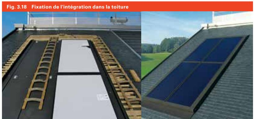
Les cadres et tôles de couverture des capteurs Viessmann et les boîtiers de raccordement sont disponibles dans toutes les teintes RAL et assurent une transition harmonieuse entre la surface du capteur et la toiture.
