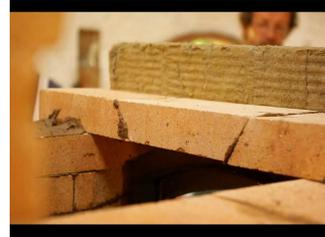
Il a les dimensions du foyer + les deux appuis soit :  $46 + 12 + 12 = 70$  cm. Un linteau en fer revient bien moins cher, est plus solide et a une durée de vie supérieure. Dilatation d'une cornière de 70 cm : 3,03 mm pour une température de 300°C. Dilatation des briques au dessus :  $70 \text{ cm} \times 0.03 \text{ mm/m} = 2 \text{ mm}$  à 300°C : la différence, 1 mm est minime. Les briques sont posées sur le linteau, sans joint ni céramique ni colle, pour quoi faire d'ailleurs?
