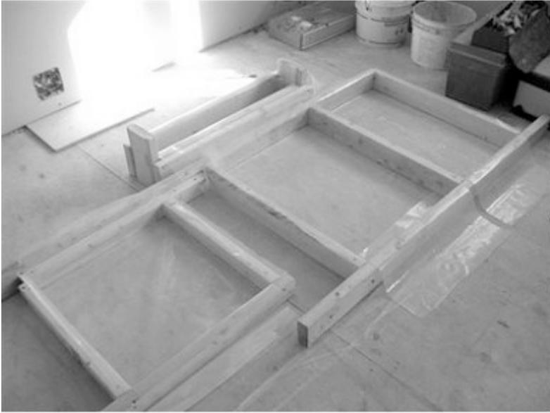
Moule pour les modules qui formeront le four, préparé avec du polyéthylène, prêt à être recevoir avec le béton réfractaire. De gauche à droite dalle de foyer, dalle supérieure, dalle arrière, et charge soulageant le linteau à l'arrière.
