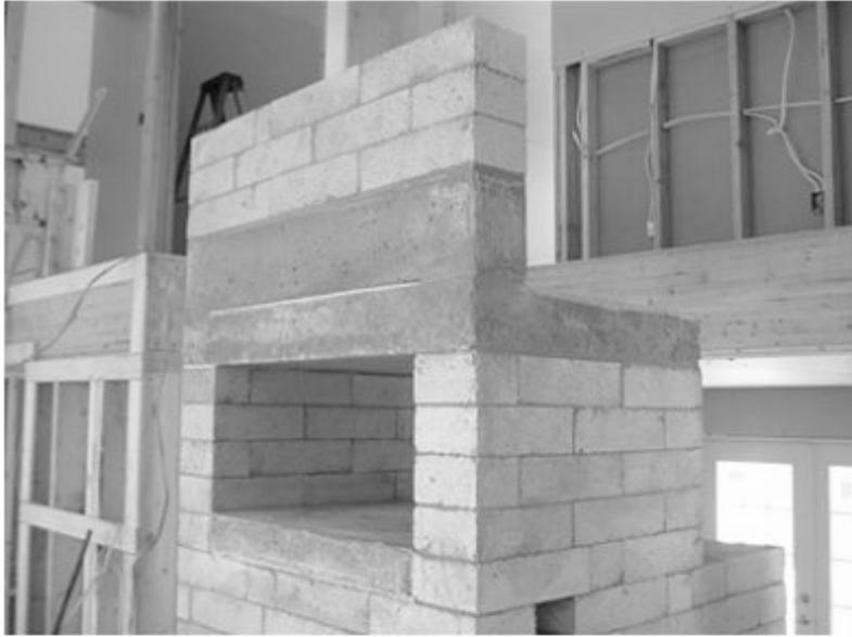
Le foyer du four, les murs latéraux, la dalle supérieure, et la charge soulageant le linteau. La dalle arrière du four n'est pas encore installée.
