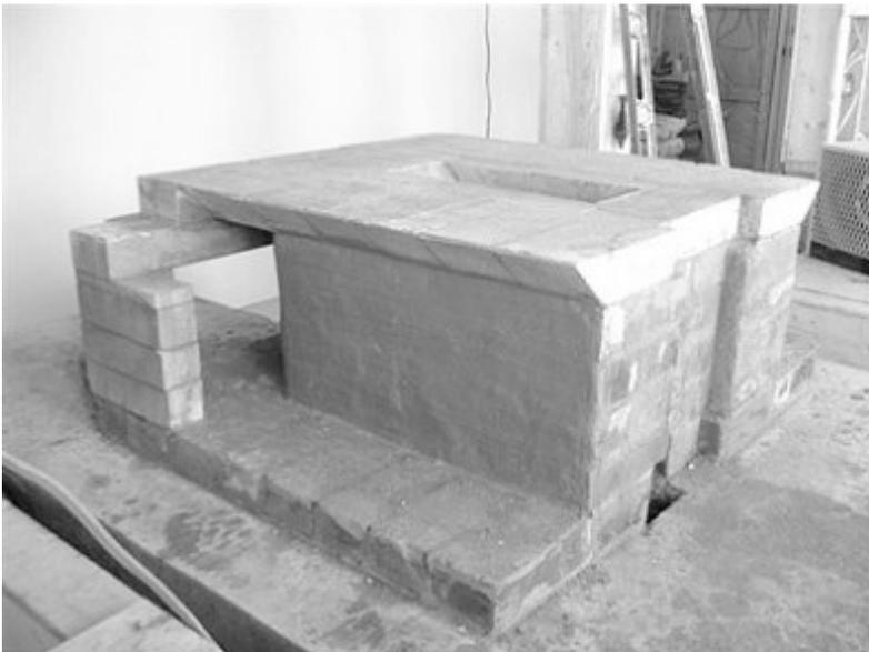
Le mur arrière du conduit de fumée est maçonné en brique réfractaire, la connexion du conduit de cheminée est négociée, et la première des deux rangées qui formeront le foyer est maçonnée. Cet étape représente le changement de largeur du conduit latéral qui est réduit de 12.5cm à 16.5 centimètres..
