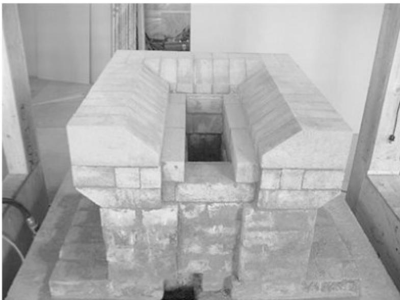
Le foyer à angles. Le plan incliné du foyer aide les braises à venir au-dessus de la grille et accélère les étapes du feu. Ceci permet au clapet d'être fermé plus tôt, réduisant ainsi la perte de chaleur.
