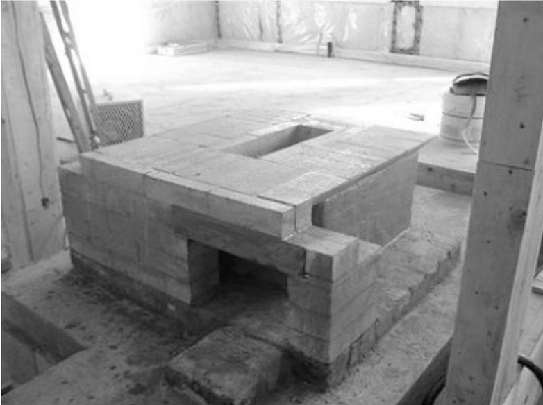
L'ouverture, dans la tubulure arrière, pour la tuile de recouvrement d'argile qui reliera le réchauffeur à la cheminée. C'est une tâche potentielle de la semaine et le travail là-dessus ou autour doit être effectué avec soin.
