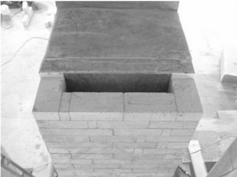
Le mur arrière du réchauffeur qui forme le conduit de fumée et qui tient la dalle arrière du four en place.
