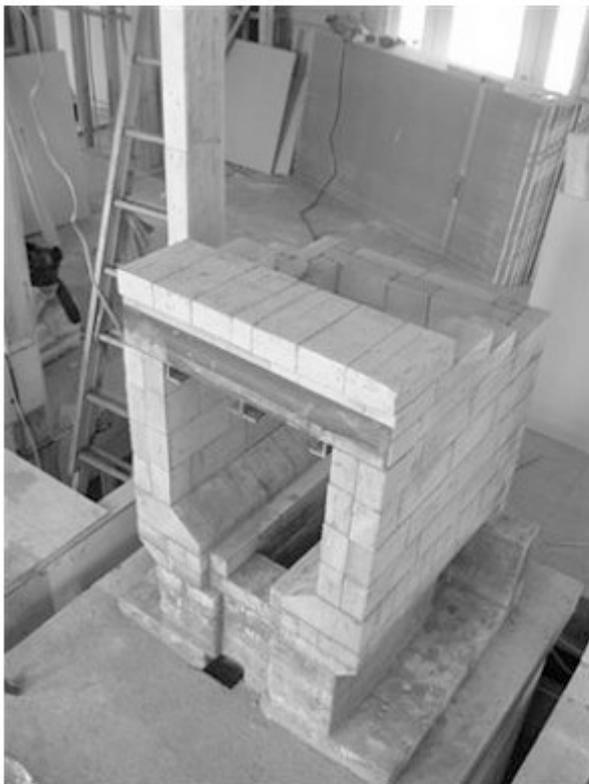
Les trois premiers rangs au-dessus du linteau sont d'une importance cruciale, et le liant utilisé doit être soigneusement considéré..
