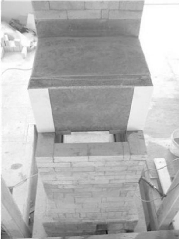
La dalle arrière du four en place et le début du mur arrière du conduit de fumée. Le côté chaud de la dalle est également garnis avec papier céramique.
