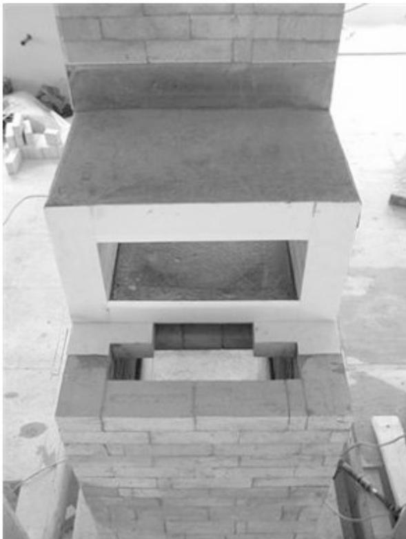
La face arrière du four, les murs latéraux, le foyer, la dalle supérieure, avec les garnitures. Préparer pour l'installation de la dalle arrière.
