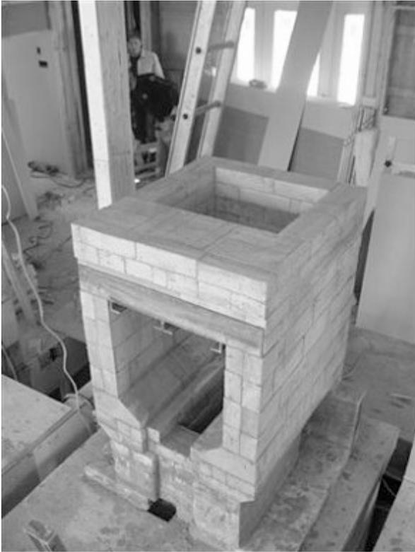
Le plafond de foyer se ferme sur le mur arrière ainsi que chaque la rangée de l'encorbellement.
