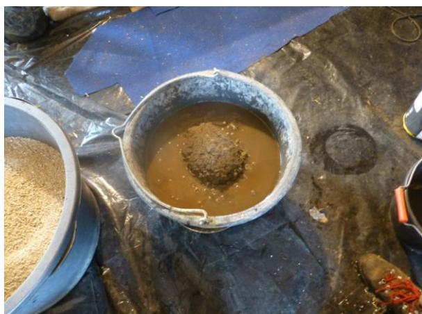
Pour le mélange isolant fabriquer une barbotine de ciment. En proportion 1 volume d'eau pour 1 volume de ciment. Laisser le ciment s'hydrater dans l'eau quelques minutes. Dès qu'il ne fait plus de bulle, malaxe rapidement.
