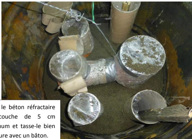
Coulez le béton réfractaire par couche de 5 cm maximum et tassez-le bien à mesure avec un bâton.
