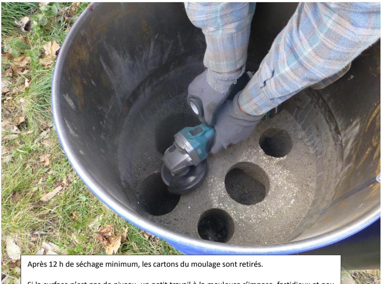
Après 12 h de séchage minimum, les cartons du moulage sont retirés.
