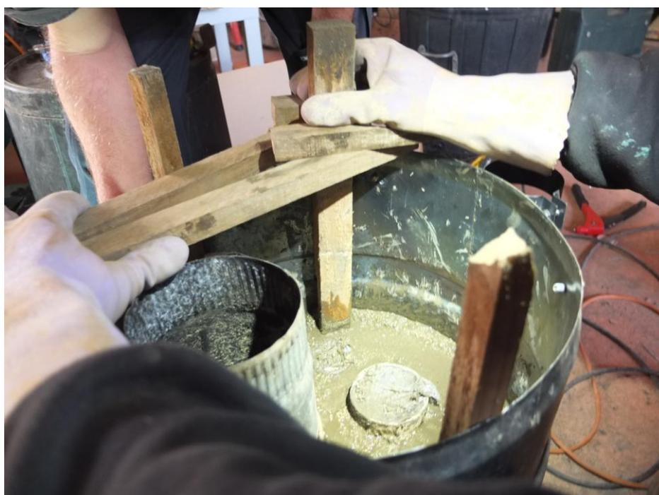
Un outil efficace pour dresser le béton de niveau : le trusquin à bidon ! Le bois vertical qui dresse est muni de 2 butées vissées qui reposent sur les tasseaux horizontaux posés sur le bord du fût.
