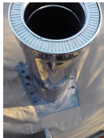
Isolation : si ton toit est isolé assure la continuité de l'isolation avec un isolant incombustible dans le distance de sécurité > laine minérale, béton de vermiculite ...
