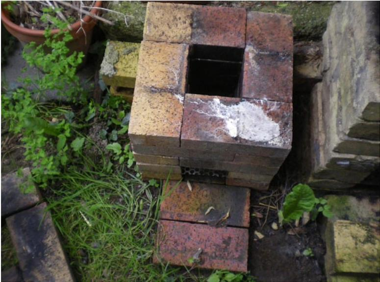
7e et dernier étage. On ajoute une brique sur la partie devant, à la fois pour soutenir le bois horizontalement et pour régler le tirage en l'approchant ou en l'éloignant de l'entrée d'air. 3 ou 4 bouts de feraille ou cailloux pour poser la casserole ou une ardoise qui transforme le rocket stove en plancha.
