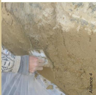
Le béton d'argile s'applique au jeté ou au platoir. Il est envisageable de réaliser plusieurs passes à quelques heures d'intervalle.
