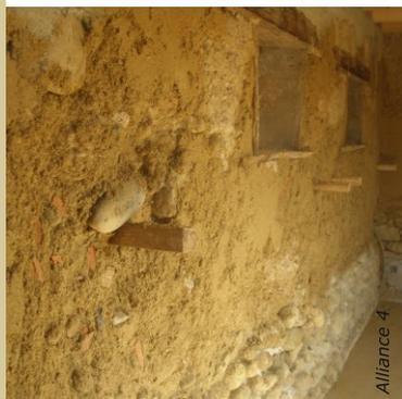
Les murs très abîmés sont rebouchés en plusieurs passes de béton d'argile. Des pierres ou des adobes sont insérées dans les gros trous.
