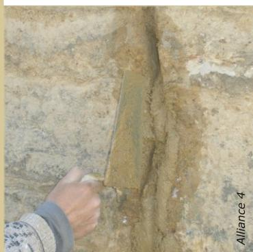
Pour le rebouchage des fissures, humidifier et insérer le mortier profondément.
