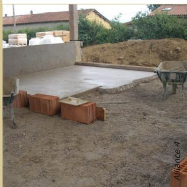
La seconde passe est mise en place, puis nivelée à la règle.
