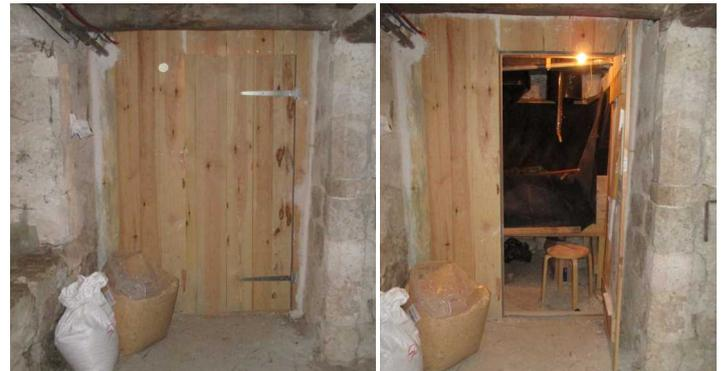
Photos : le composteur est dans une cave (murs existants en pierre) fermé par une cloison et une porte en bois comprenant des joints
