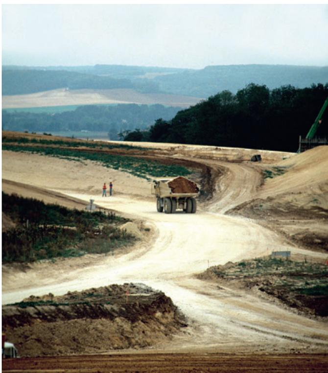
Un tracé adapté des pistes limite l'usure en cône
