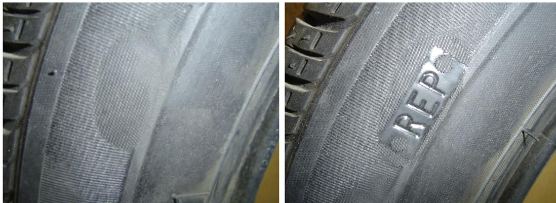
Mise en place d'un bouchon de gomme vulcanisé à chaud
