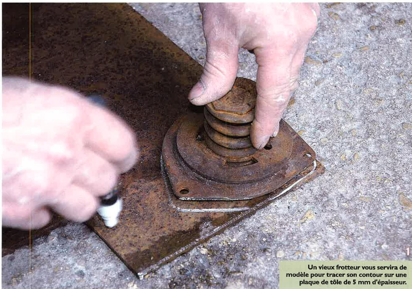
Un vieux frotteur vous servira de modèle pour tracer son contour sur une plaque de tôle de 5 mm d'épaisseur.
