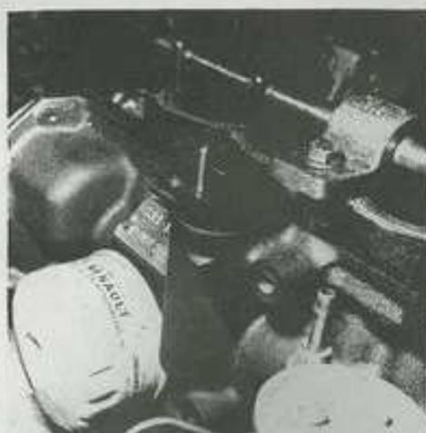
Montage du pignon de commande d'allumeur (boulon  $\varnothing$  12 mm au pas de 175)
